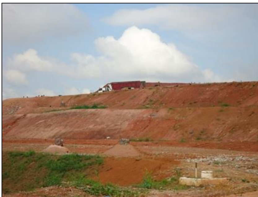
Figura 9 – Vista do aterro de Brusque Fonte: Premier Engenharia, 2018.
